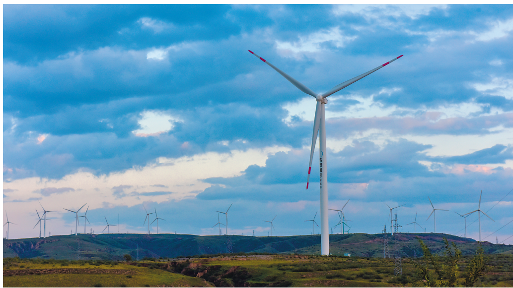
近年来,新荣区新能源项目建设按下快进键,仅今年就开工建设风电项目48兆瓦、光伏项目10万千瓦。图为已并网发电的新荣区49.5兆瓦小窑山风电场。 本报记者 张占兵摄
