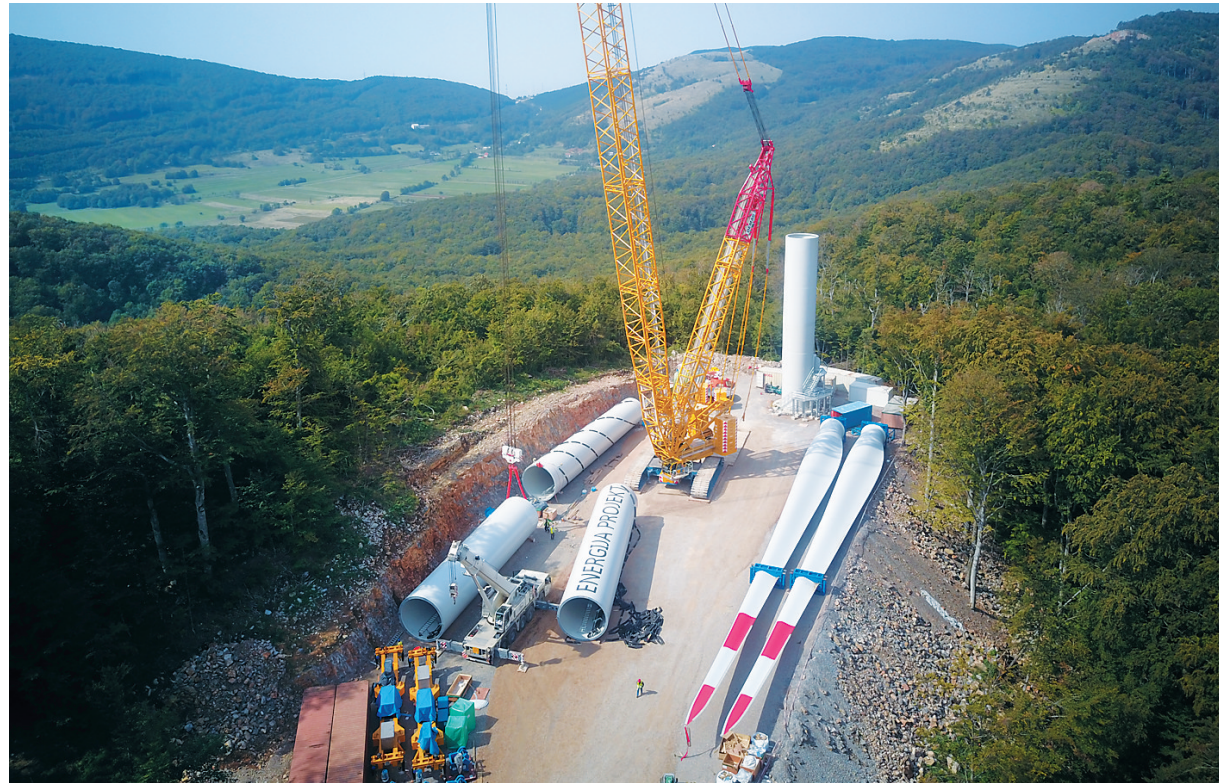
这是航拍的克罗地亚塞尼风电项目风机塔筒吊装施工现场。北方国际合作股份有限公司2017年11月收购克罗地亚能源项目公司塞尼风电项目76%的股权,并获得项目建设权及长达25年的运营权。塞尼风电项目总装机156兆瓦,建成后预计年均发电3400小时,年发电量5.3亿度,预计2021年6月全部建成并网发电,目前已进入施工高峰期。新华社记者 高磊摄
