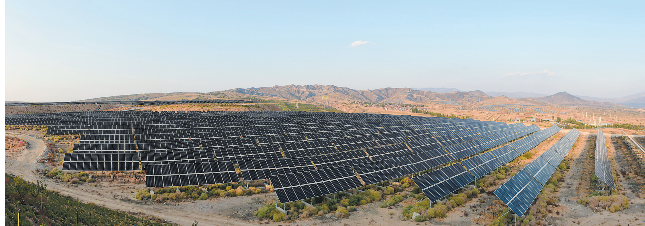
图为浑源县阳光矿山生态修复工程林光互补光伏电站。
