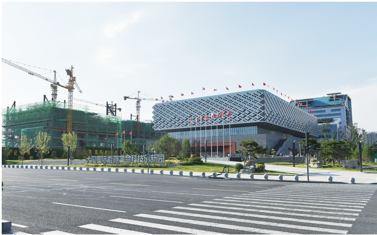
大同能源馆是我市推进转型综改的新地标。
