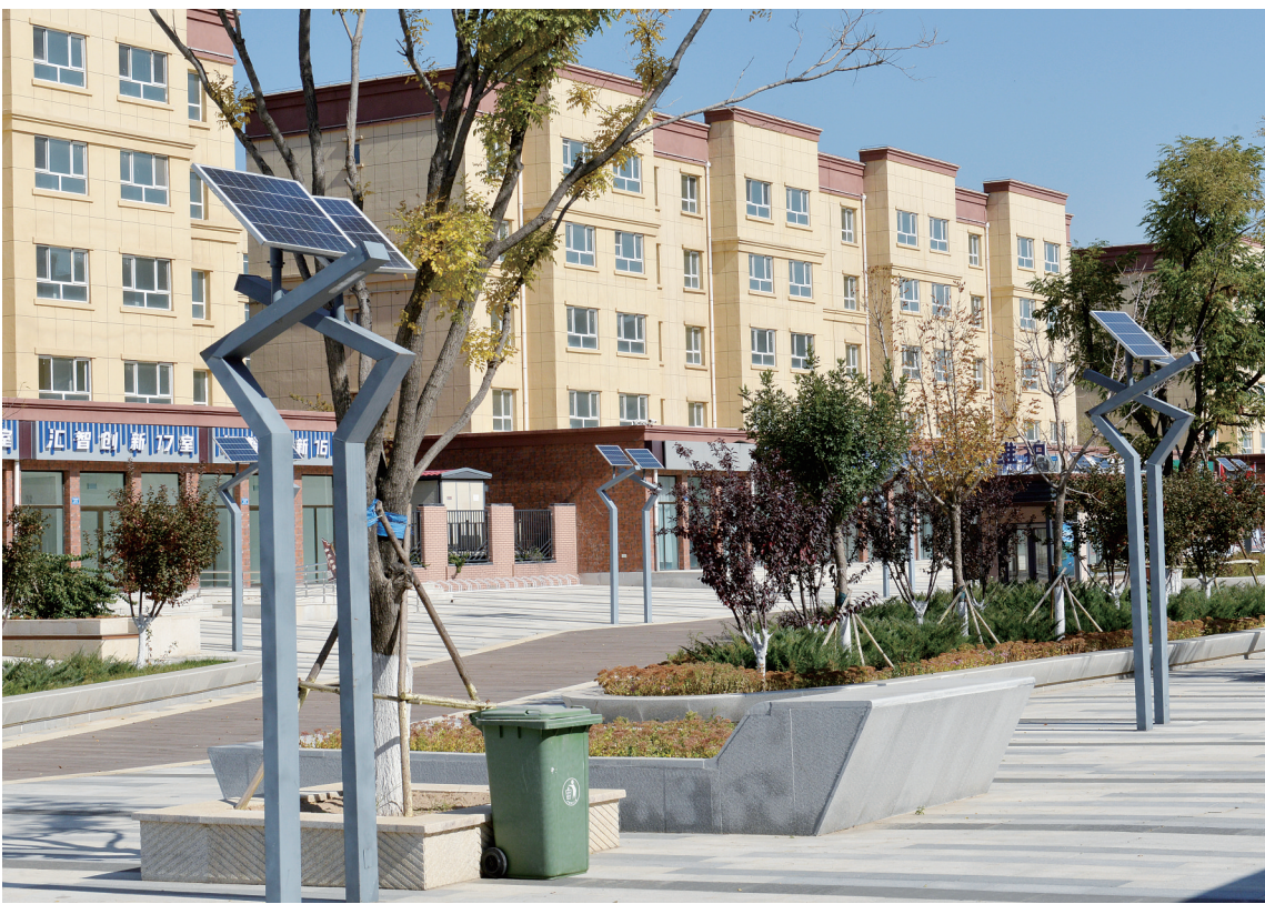
在转型汇智创新城汇智大街,60组太阳能路灯在道路两侧均匀分布,每组太阳能路灯有两个灯头,可以同时照亮路面中心和人行步道区域,展示出转型汇智创新城的创新特色。本报记者 戎禹仁摄
