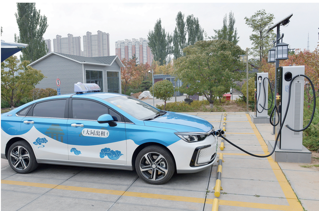
纯电动汽车作为新能源汽车的重要成员,以其零污染、低能耗的显著优势,逐步融入市民的日常生活中。为了方便电动汽车能够及时充电,我市在部分地段陆续建设了电动汽车充电站。大同平城新能源科技有限公司在东城墙带状公园和西城墙带状公园的停车场内,建设完成了4所智能充电站,这4所智能充电站共安装55个充电桩,可同时满足110辆电动车的充电需求。因为新能源车电动出租车正在充电站内充电。本报记者 戎禹仁摄
