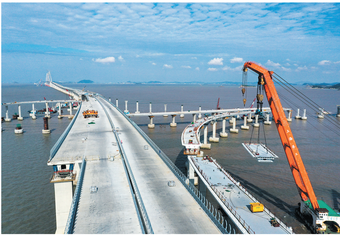
10月28日,在舟岱大桥海上互通(长白互通)D匝道施工区,大型机械在吊装钢箱梁(无人机照片)。
