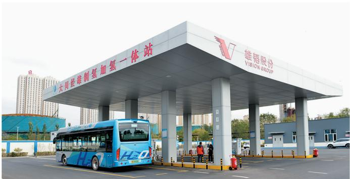
我市201路、62路两条氢能公交线路已全部上线运营,为保障氢气的供应,位于开源街南侧的制氢加氢一体站内,制氢机和压缩机设备每天在高速运转。据了解,通过电解槽产生的高纯度氢气经过干燥设备净化、压缩机增压,每天可生产500公斤氢气,可满足70多辆氢能公交车的加氢需求。图为氢能公交车正在站内加注氢气。 本报记者 戎禹仁摄
