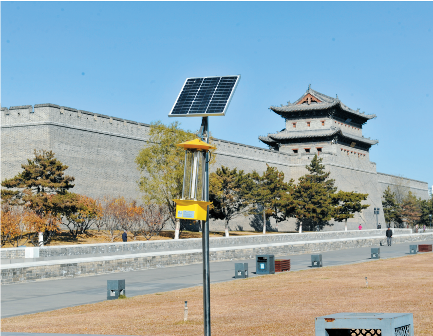
图为东城墙带状公园安装的太阳能杀虫灯。太阳能杀虫灯白天接收太阳光并进行储能，晚间智能电控系统自动启动紫外线光源，开启太阳能灯，产生光亮诱杀害虫，照明与灭虫兼而有之，市民为此点赞。 本报记者 于宏摄
