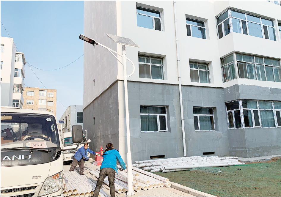
图为在平城区东风园小区实施的老旧小区住宅综合整治工程中，施工人员正在安装太阳能路灯。据悉，目前该小区已经完成改造工程量的90%，包含基础设施、节能改造、服务设施提升等10项改造内容。
