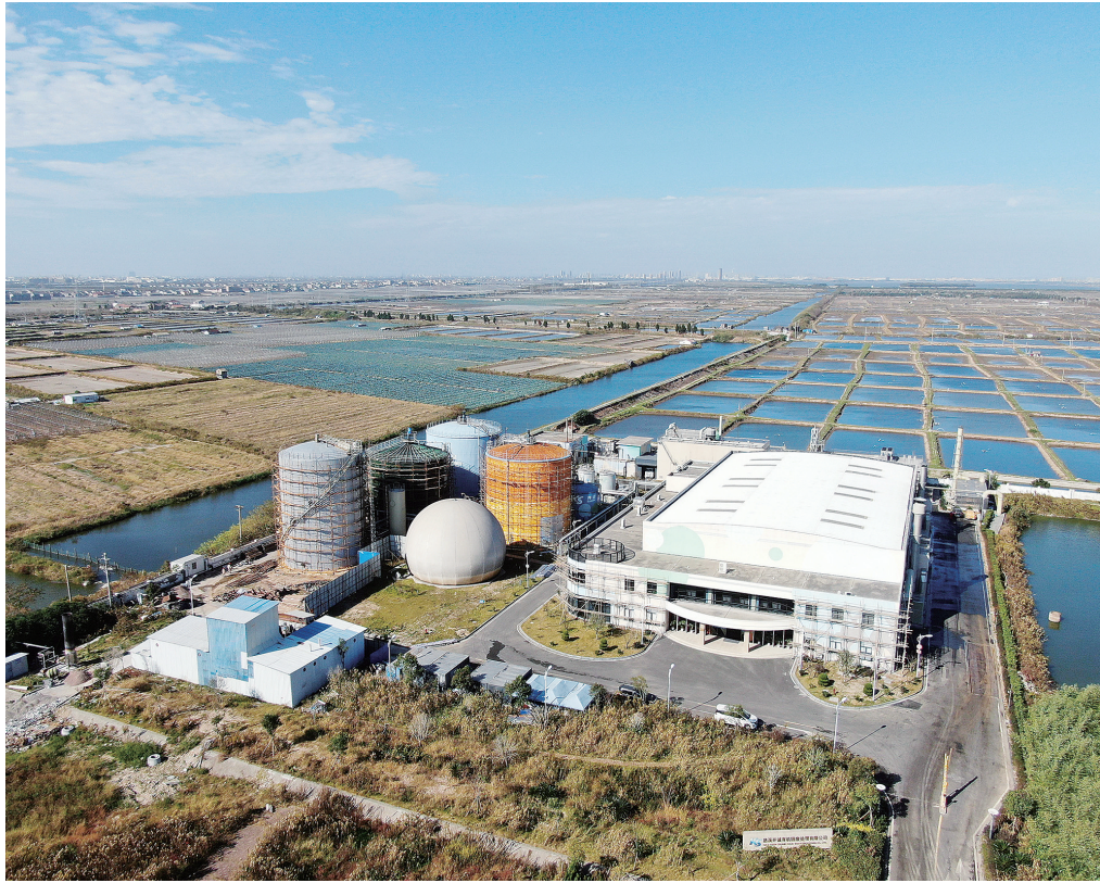
浙江省宁波市首个餐厨垃圾沼气发电项目在慈溪开诚有机固废处理有限公司近日投运并网。该项目配备800千瓦的沼气发电机组及配套餐厨垃圾处理设施,利用餐厨垃圾油水分离、中温厌氧等过程产生的沼气用于发电,预计年处理餐厨垃圾约70000吨、年发电量600多万千瓦时,所发电量全部并入国家电网。图为宁波首个餐厨垃圾沼气发电项目(无人照照片)。 新华社记者 徐显摄
