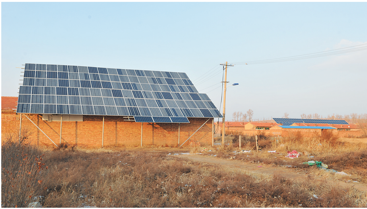
图为并网发电的新荣区新荣镇安庄村屋顶光伏。我市各县区积极推进乡村家庭屋顶光伏惠民工程，实现了资源综合利用，也为当地群众尤其是建档立卡贫困户拓宽了增收渠道。本报记者 于宏摄
