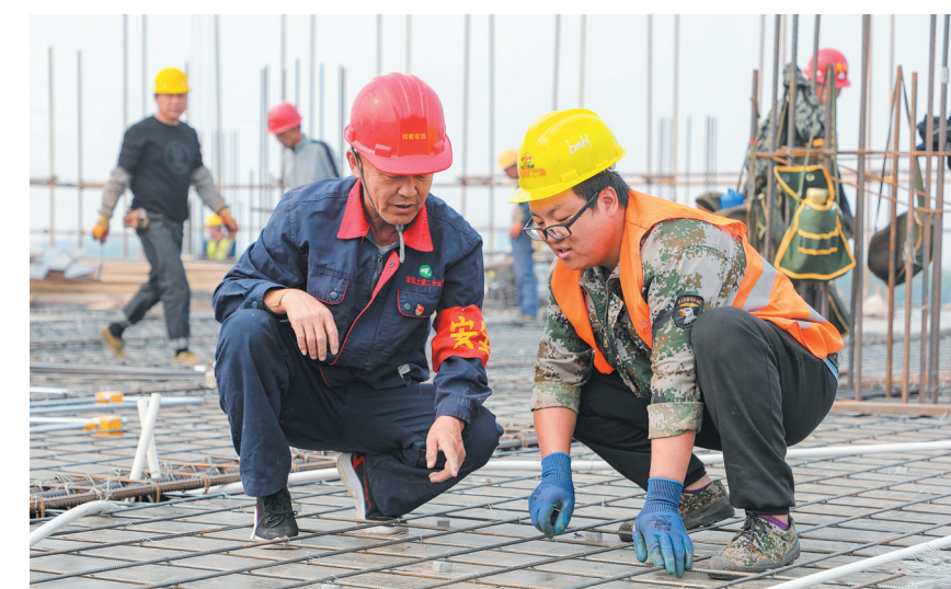
宏远公司下大力气抓好施工安全管理,盯现场、查“三违”,增强管理人员安全防范意识,杜绝各类安全事故发生。图为安全技术人员在煤基产业研发中心项目工地进行安全交底。
