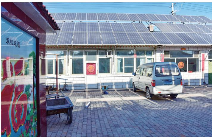
图为左云县张家乡乡云西村村民张富投资安装的30KW户用屋顶分布式光伏电站。该电站已并网发电3年,据张富估算,6年就可以收回成本,按照使用寿命25年计算,可以再有19年稳定收入。本报记者 张占兵摄
