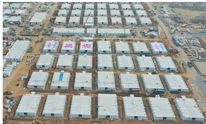
这是1月19日拍摄的石家庄黄庄公寓集中隔离场所工地（无人照照片）。当日，石家庄黄庄公寓集中隔离场所将有606套隔间房和配套设施交付，按计划20日将再交付1173套，总量达到1779套。其它各项工程也在抓紧往前赶。据介绍，项目选址在正定和藁城交界的黄庄村南，实际占地658亩，建筑规模从最初的3000套增加到4156套。 新华社记者 杨世尧摄
