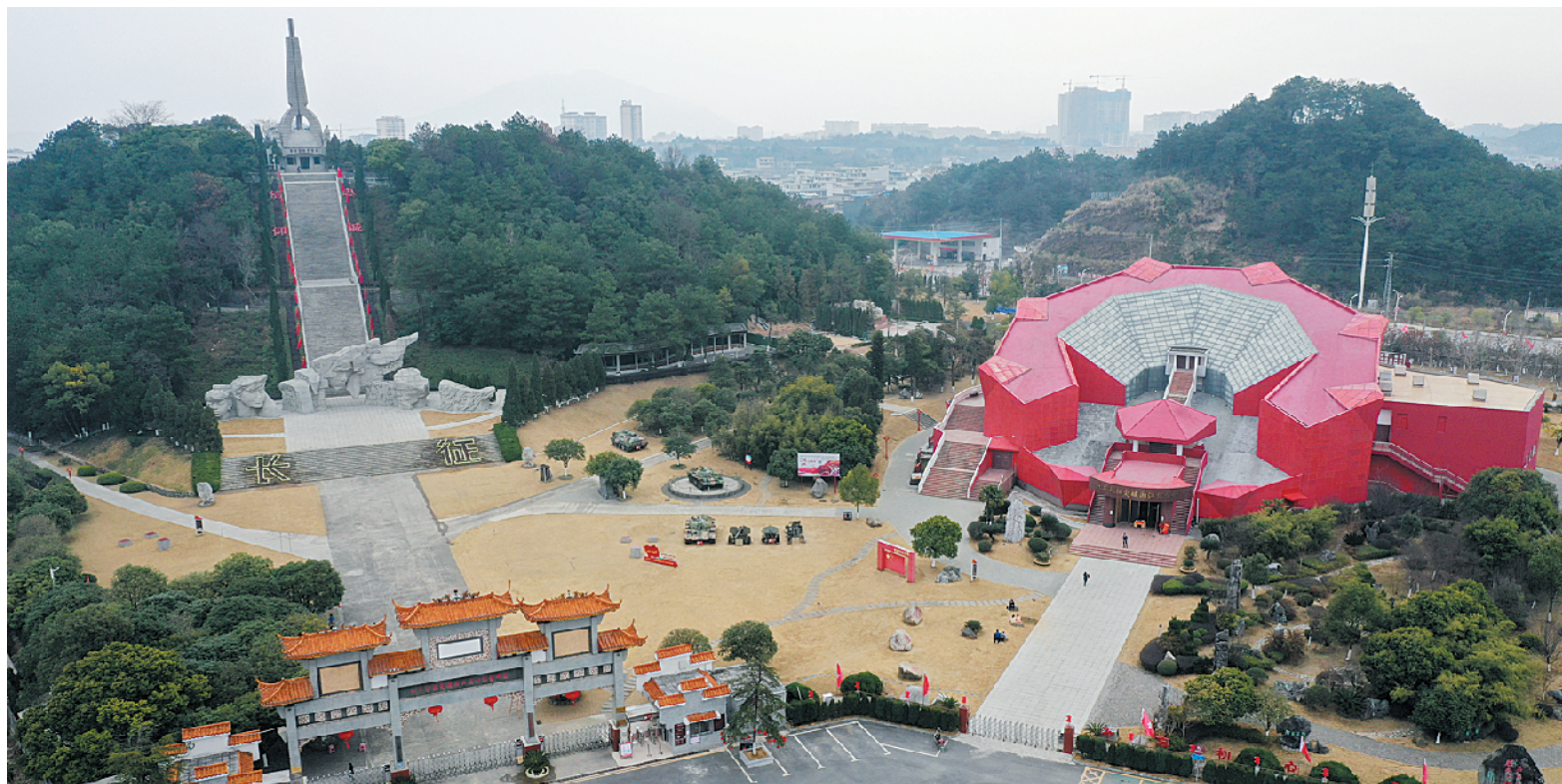
这是广西兴安红军长征突破湘江烈士纪念馆(2月2日摄，无人机照片)。 新华社记者 陆波岸摄
