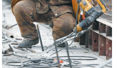
春节期间,5500余名参与建设我国首条民营控股高铁——杭绍台铁路的员工坚守岗位就地过年,工人们利用晴好天气奋战在工地上,稳步推进工程进度。新华社记者 黄宗治摄
