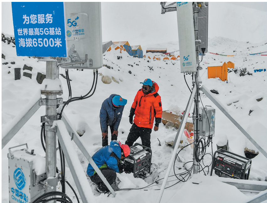
在海拔6500米的珠峰前进营地,中国移动工作人员在调试5G基站(2020年5月21日摄)。
