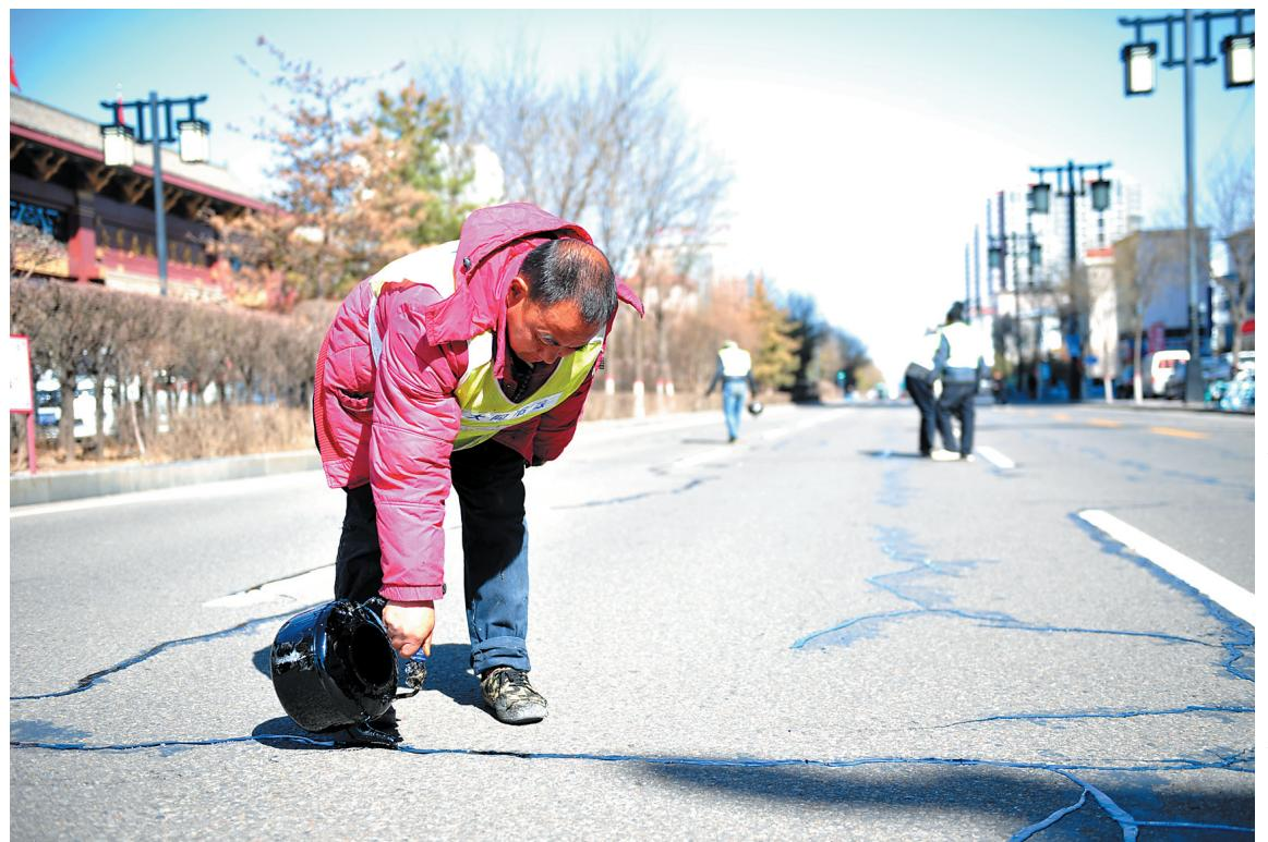
从3月16日起，市城市道路管理所对辖区内的总长度800多公里的道路开展春季路面灌缝，防止路面进一步开裂、渗水、老化，改善路况。图为3月22日，工作人员在魏都大道向阳街十字路口南侧实施道路路面灌缝养护工作。
