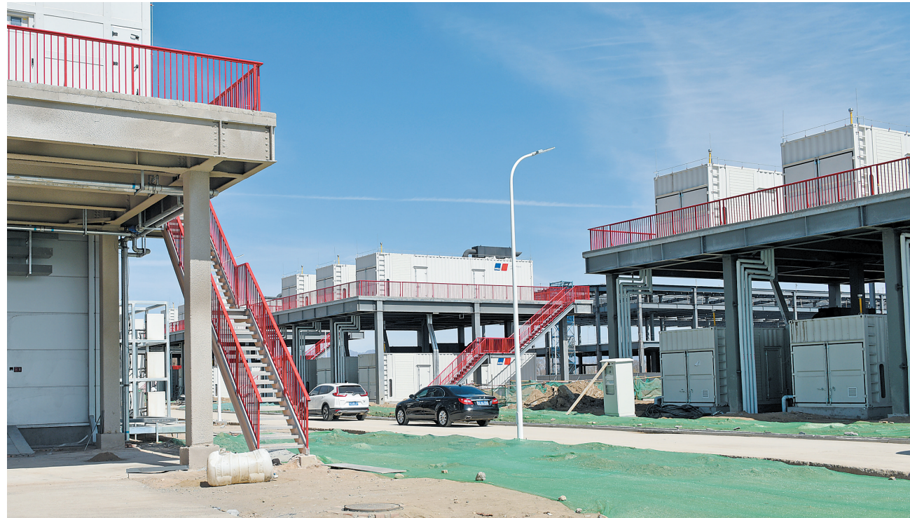
位于阳高县的山西中云智谷数据科技有限责任公司中联绿色大数据产业基地项目,于2020年6月开始建设。目前,该项目一期工程1号2号机房楼已建成,进入投运阶段;3号4号机房楼及研发中心主体钢结构已完成施工。预计年内3号4号机房楼建成投运,5号6号机房楼主体完工,研发中心投入运行。据了解,公司主要与京东、阿里、微软、字节跳动等公司开展合作,该项目分三期建设,全部建成投产后,将成为华北地区、环京津冀地区超大规模数据中心承接及转换基地。
