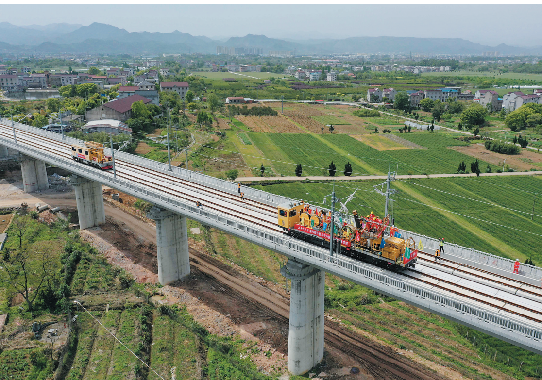
4月18日,施工人员在杭绍台铁路上进行接触网导线架设作业(无人机照片)。 当日,由中国中铁电气化局参建的杭绍台铁路在浙江天台县开始架设第一条接触网导线,标志着杭绍台铁路电气化工程进入核心技术施工阶段。据了解,杭绍台铁路全部接触网导线架设及调整施工计划于7月底完成。 新华社记者 黄宗治摄
