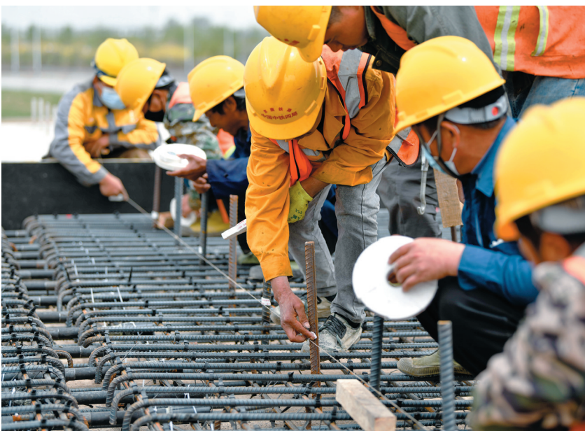
5月23日，中铁四局工人在河北省唐山市境内京唐铁路七标段施工现场绑扎钢筋。记者从中铁四局了解到，京唐铁路七标段施工进度顺利，所有连续梁已完成合龙。京唐铁路是京津冀地区轨道交通网络的重要组成部分，其中七标段沿途跨越多条交通主干道，桥梁总长度超过21公里。新华社记者 牟宇摄
