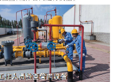
工作人员检查管网设备
