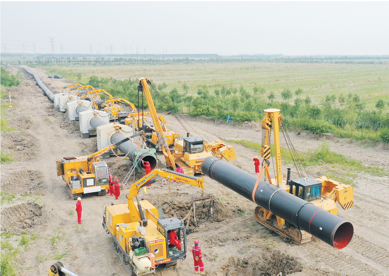
6月24日，工人在唐山市丰南区王兰庄镇境内的曹妃甸区新天LNG接收站外输管线项目(曹妃甸—宝坻段)建设工地施工（无人机照片）。
