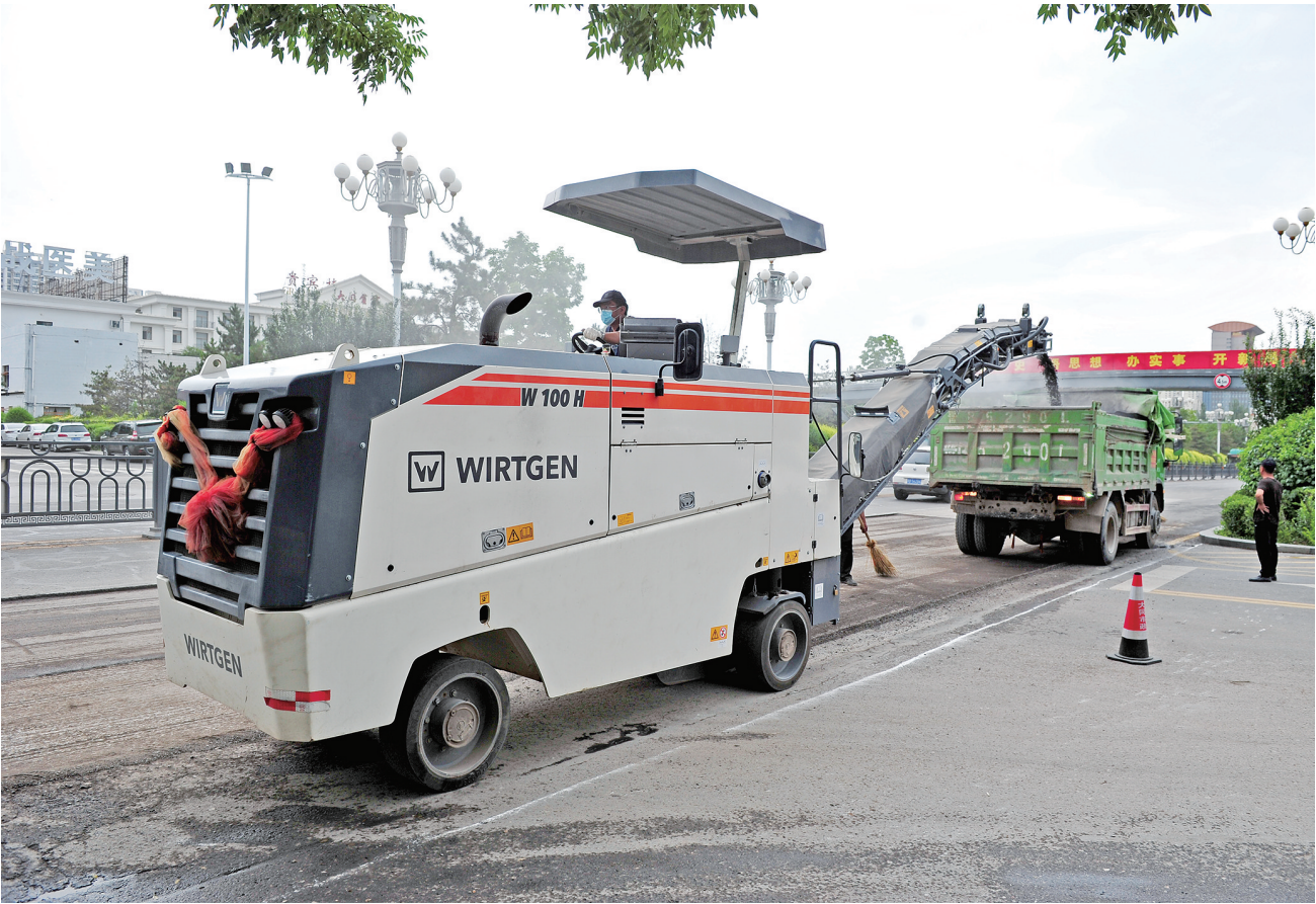
迎宾街自2008年道路改造后，经多年使用，路面出现不同程度的裂缝、松散、坑槽等病害，不仅影响行车舒适度，而且为行车安全埋下隐患。6月中旬起，市城市管理局与市公安局交警支队联合对迎宾街道路进行优化提升，为行人和车辆打造舒适的通行环境。其中，5个岗区由市公安局交警支队承担，其余道路部分由市城市管理局承担。图为7月15日，在迎宾街红旗街口，市城市管理局出动大型铣刨机对病害路面进行铣刨作业。 本报记者 于宏摄
