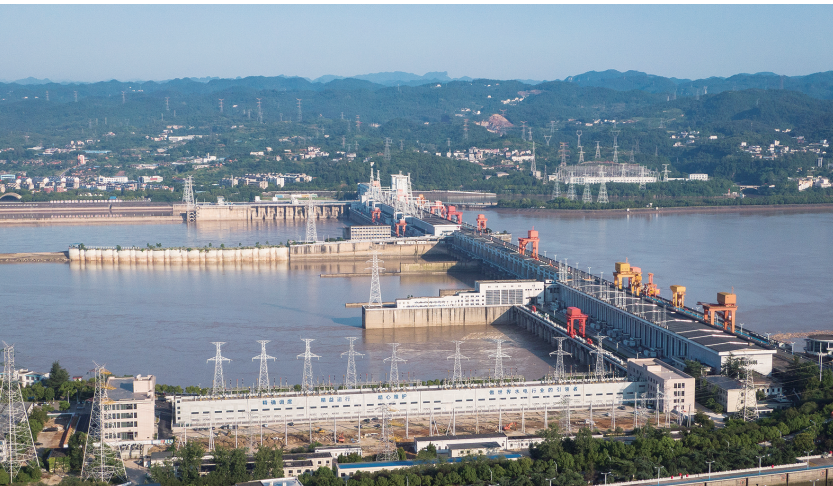
7月30日拍摄的葛洲坝水利枢纽(无人照照片)。被誉为“万里长江第一坝”的葛洲坝水利枢纽,自1981年7月30日首台机组并网发电,为我国社会经济发展注入了强大活力。40年间,这座“万里长江第一坝”为社会累计生产清洁能源近6000亿千瓦时,相当于节约标煤约1.84亿吨,减排二氧化碳5.03亿吨。 新华社记者 肖艺九摄
