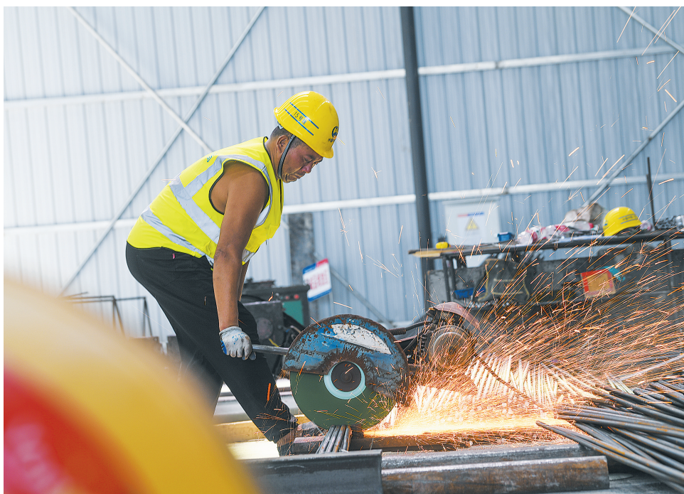
近日,重庆持续高温天气。由中铁一局承建的重庆轨道交通15号线一期土建工程04标段建设者们不畏酷暑,抢抓施工进度。图为8月3日,建设者在重庆轨道交通15号线一期土建工程04标段钢筋加工车间作业。 新华社记者 王全超摄
