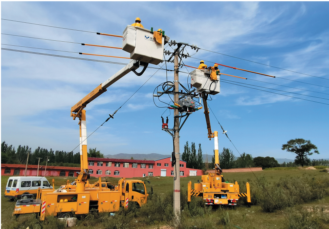
国网山西省电力公司左云县供电公司常态化推行“带电作业、零点作业、错峰作业”，在保障安全的前提下，确保居民生产生活用电。8月26日，该公司为左云县三屯乡黄村附近的10千伏电杆带电加装了柱上智能开关，据悉，本次作业共计减少停电306户时。
