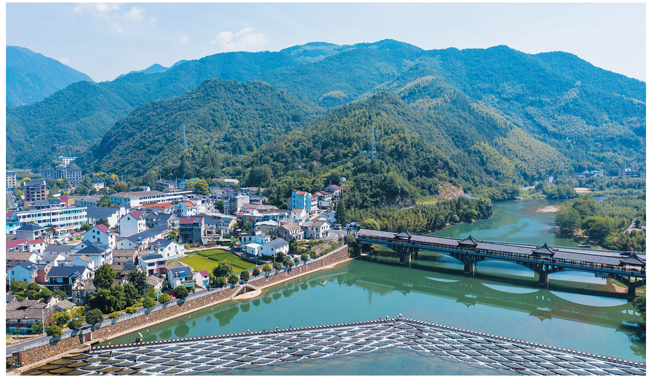
空中俯瞰湖源乡龙鳞坝(9月2日摄,无人机照片)。浙江省杭州市富阳区湖源乡龙鳞坝位于湖源乡新一村和新绿村之间的一条生态堰坝,于2017年上半年完工。龙鳞坝全长170多米,从上到下一共13层,坝体上的每块“龙鳞”都是一个小的蓄水池,水流经过便会形成错落有致的弧形瀑布,与上游的廊桥构成了一幅美丽的山乡美景,吸引了众多的游客前来观赏体验。新华社记者 徐昱摄
