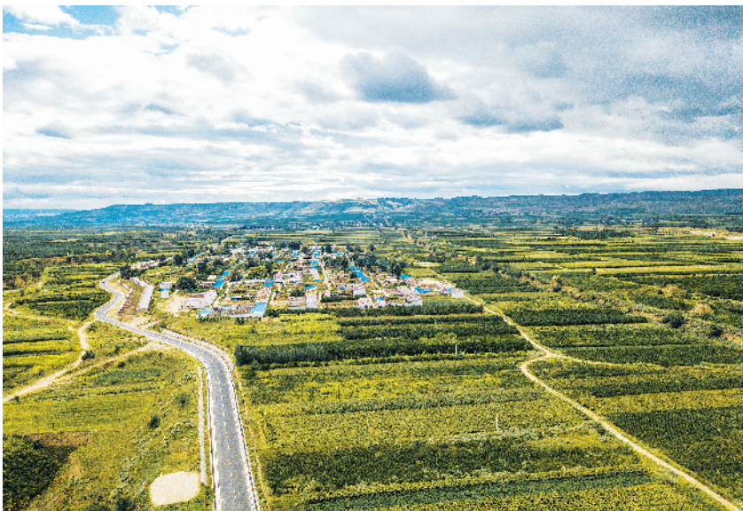
长城一号旅游公路的全线贯通,对优化农村路网结构、助力乡村振兴、改善市域交通环境、方便群众出行具有重要意义。
