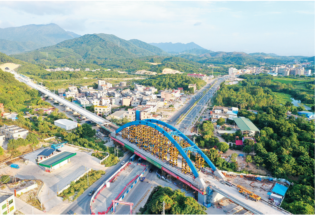
广汕铁路背子头特大桥系杆拱合龙(10月11日报，无人机照片)。 当日，由中铁十一局施工的广汕铁路背子头特大桥系杆拱在惠州市惠东县合龙，长112米的系杆拱横跨G324国道，是广汕铁路关键节点工程。设计时速350公里的广汕铁路全长266.2公里，途经广州、惠州、深汕合作区、汕尾，全线预计2023年建成通车。全线通车后，广州到汕尾运行时间将由现在的2小时左右缩短至40分钟左右，将有力助推粤港澳大湾区。 新华社记者 刘大伟摄
