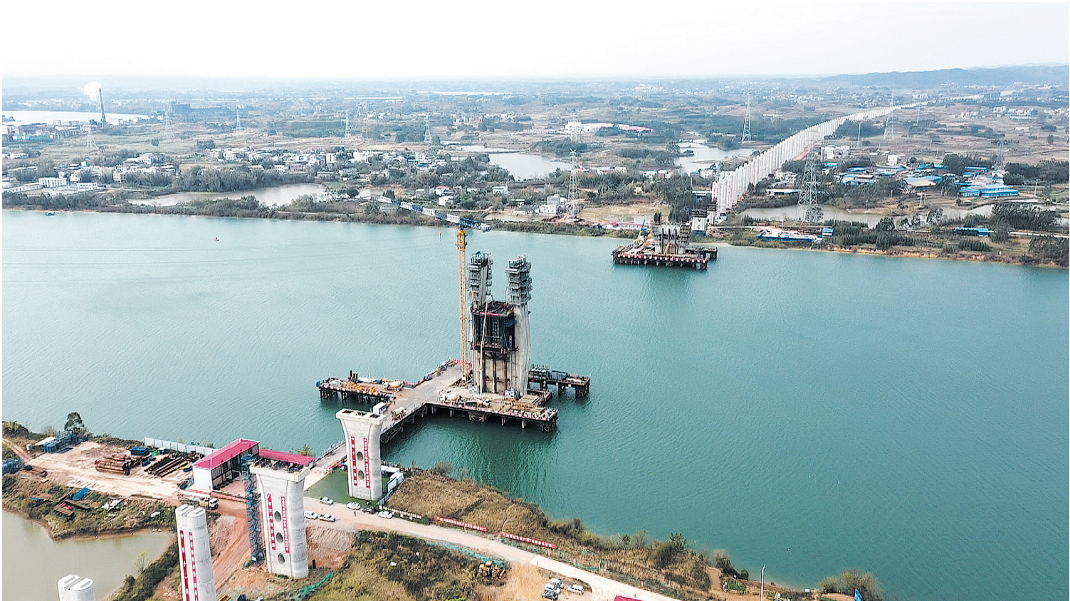
这是1月11日拍摄的建設中的南玉高铁六景都江特大桥（无人机照片）。 连日来，在南玉高铁六景都江特大桥施工现场，中铁十一局的工人克服寒潮影响，连续奋战浇筑主墩，南玉高铁工程建设有序进行。六景都江特大桥是南玉铁路控制性工程之一，主跨320米。 新华社记者 张爰林摄
