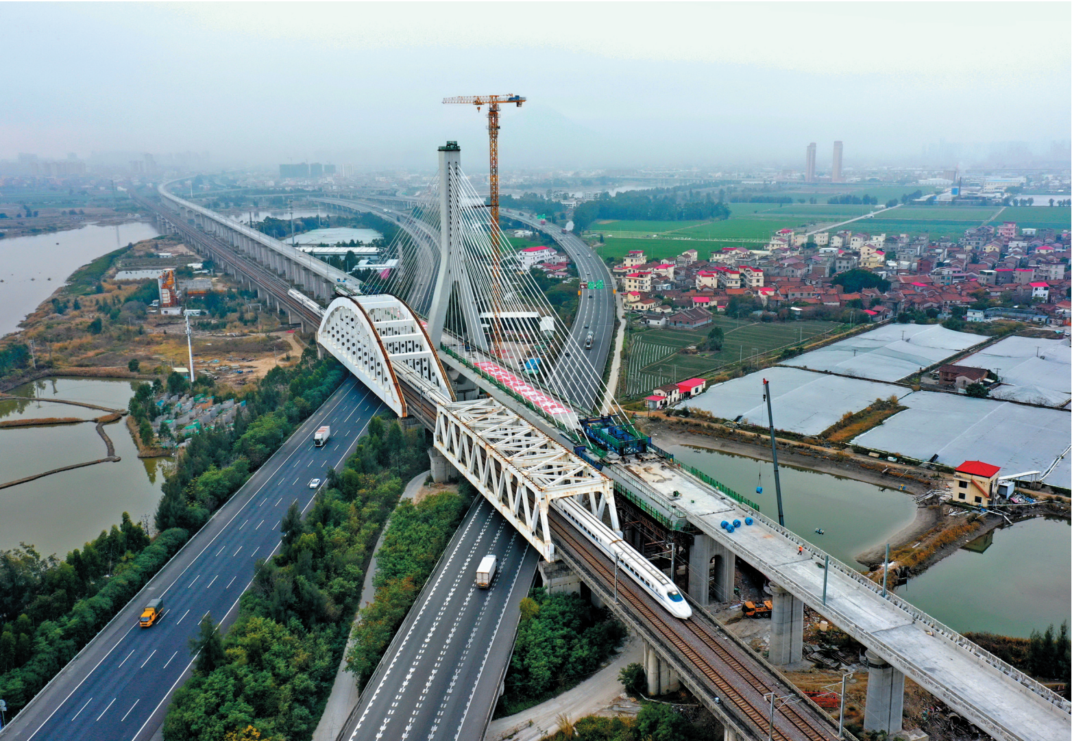
新建福厦铁路木兰溪特大桥斜拉桥主梁合龙
