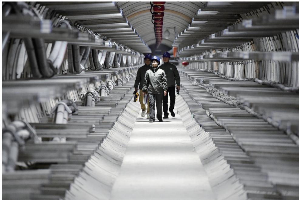
2月17日，工作人员在湖底电缆隧道内巡检。安徽省巢湖市湖光路电缆隧道位于巢湖湖底，全长780米，深度42米，隧道里有多条城市供电“动脉”。近日，合肥供电公司电缆运检中心的工作人员深入湖底隧道，对运行中的电缆进行检测，保障节后复工复产供电安全。
