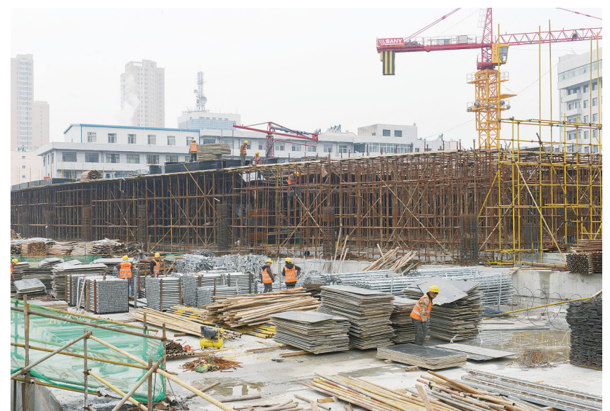
3月24日,记者在市三医院新建医技、急诊楼及配套工程项目建设现场见到,塔吊林立,机器轰鸣,200余名施工人员进行搭架及钢筋绑扎施工。该项目新建医技楼、急诊楼、临时过渡性建筑、液氧站以及智能立体车库,总建筑面积87237平方米,涉及5G网络、智能消防、新型玻璃幕墙、智能停车等多个专业领域。其中,基坑深度20.3米,是我市近年来基坑深度最深、单体建筑面积最大的公共医疗性建筑。
