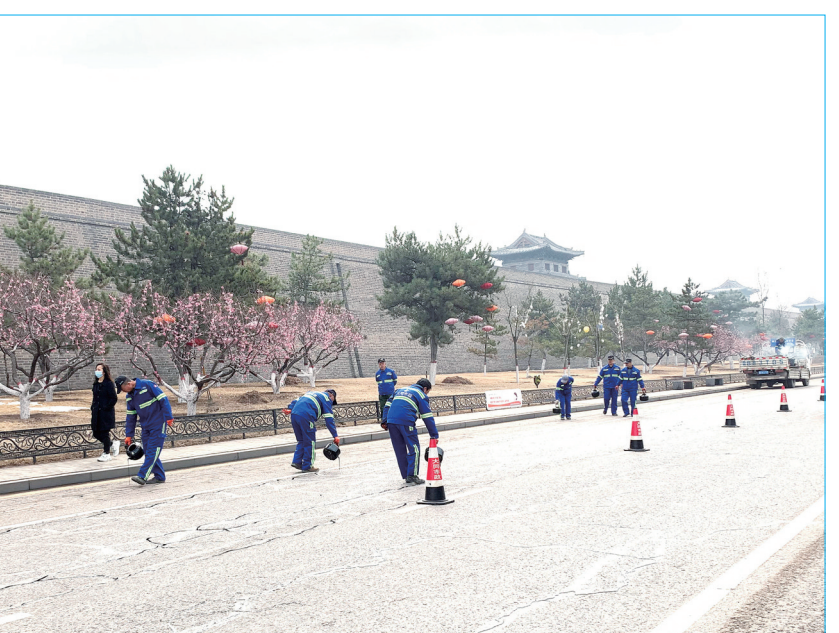
春季是市政设施养护管理的重要时期，路面经过严冬的“洗礼”后，会不同程度地出现裂缝和龟裂现象。连日来，城市道路设施服务中心开始对辖区内的道路进行科学养护。图为昨日，10余名工作人员对古城和阳内街的道路进行灌缝养护。
