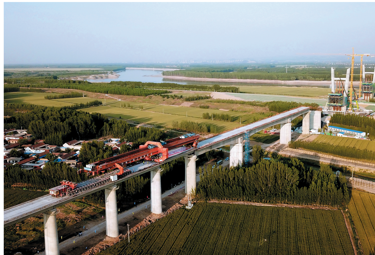
5月21日，在济郑高铁山东长清黄河特大桥施工现场，中铁上海局工作人员进行无砟轨道施工作业（无人机照片）。近期，中铁上海局统筹疫情防控和项目建设，推进国家重点基建工程——济郑高铁施工。5月21日，济郑高铁山东德州段最后一根箱梁架设完成，无砟轨道施工也于同日在长清黄河特大桥拉开序幕。据悉，本次无砟轨道施工采用我国自主知识产权的CRTSⅢ型板式技术，将为后续铺轨作业和线路开通运营创造有利条件。
