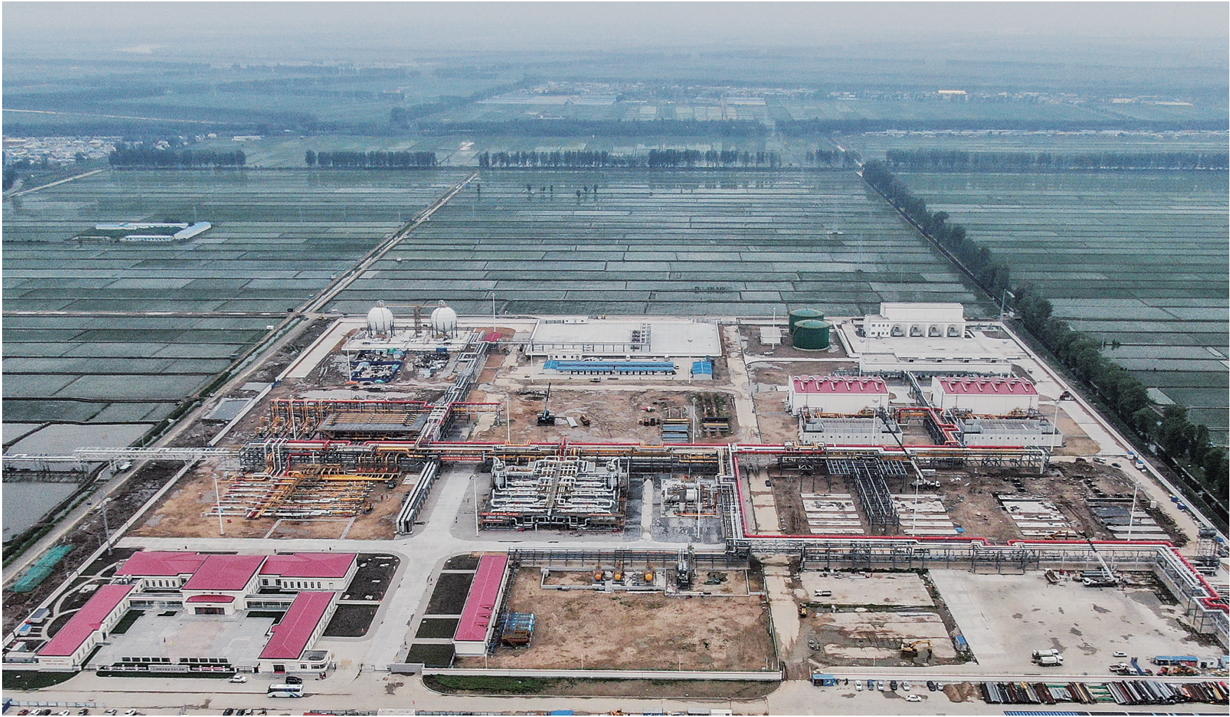
6月15日拍摄的中国石油辽河油田储气库群作业区(无人机照片)。 五月下旬，中国石油辽河油田储气库群双台子储气库国产注气系统投产成功，辽河储气库群整体日注气能力从1400万立方米提升到3000万立方米，成为全国注气能力最大的储气库群。据了解，双台子储气库国产注气系统试运的核心设备是两台国产电驱高压缩离心机，单台日处理气量可达800万立方米。本次双台子储气库注气系统投产成功极大地推动了辽河储气库群建设进程，保障今冬明春天然气供应。 新华社记者 潘昱龙摄 辽河油田双台子储气库国产注气系统投产成功
