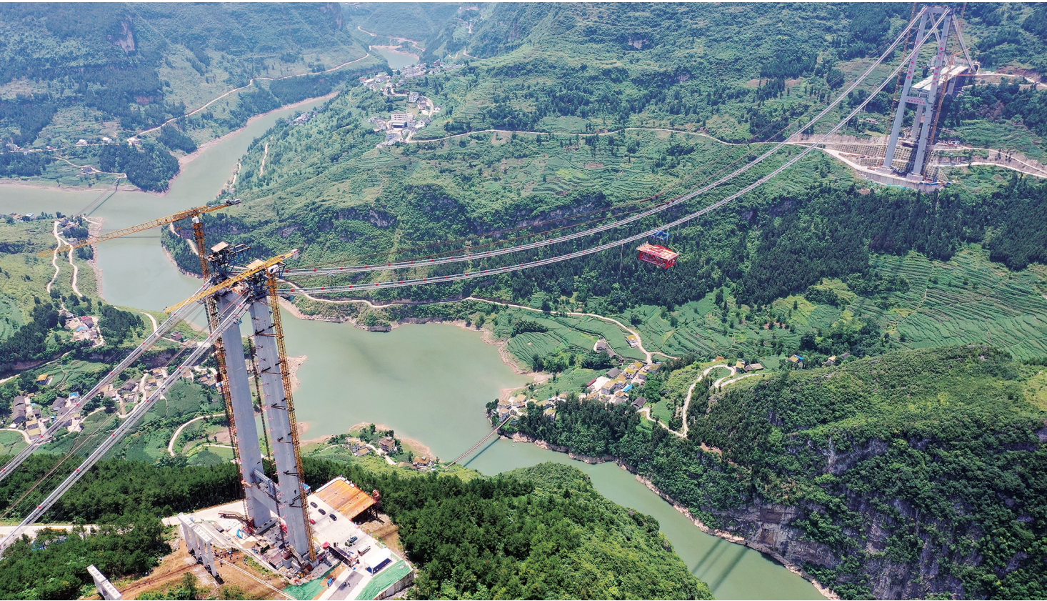
贵州金仁桐高速桐梓河特大桥首节钢桁梁开始架设
