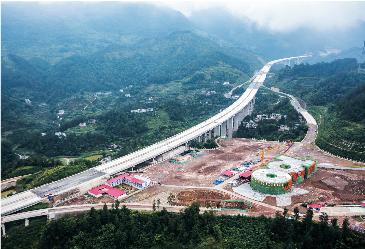
兰海高速重通扩容工程（贵州境）加紧建设
