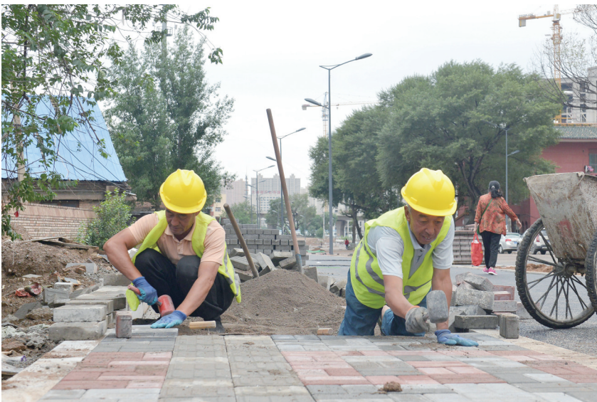
近日，我市打通10条“断头路”工程陆续开工。7月3日，记者在武州路道路施工现场看到，工人正在铺设便道砖，宽阔的道路已初具雏形。
