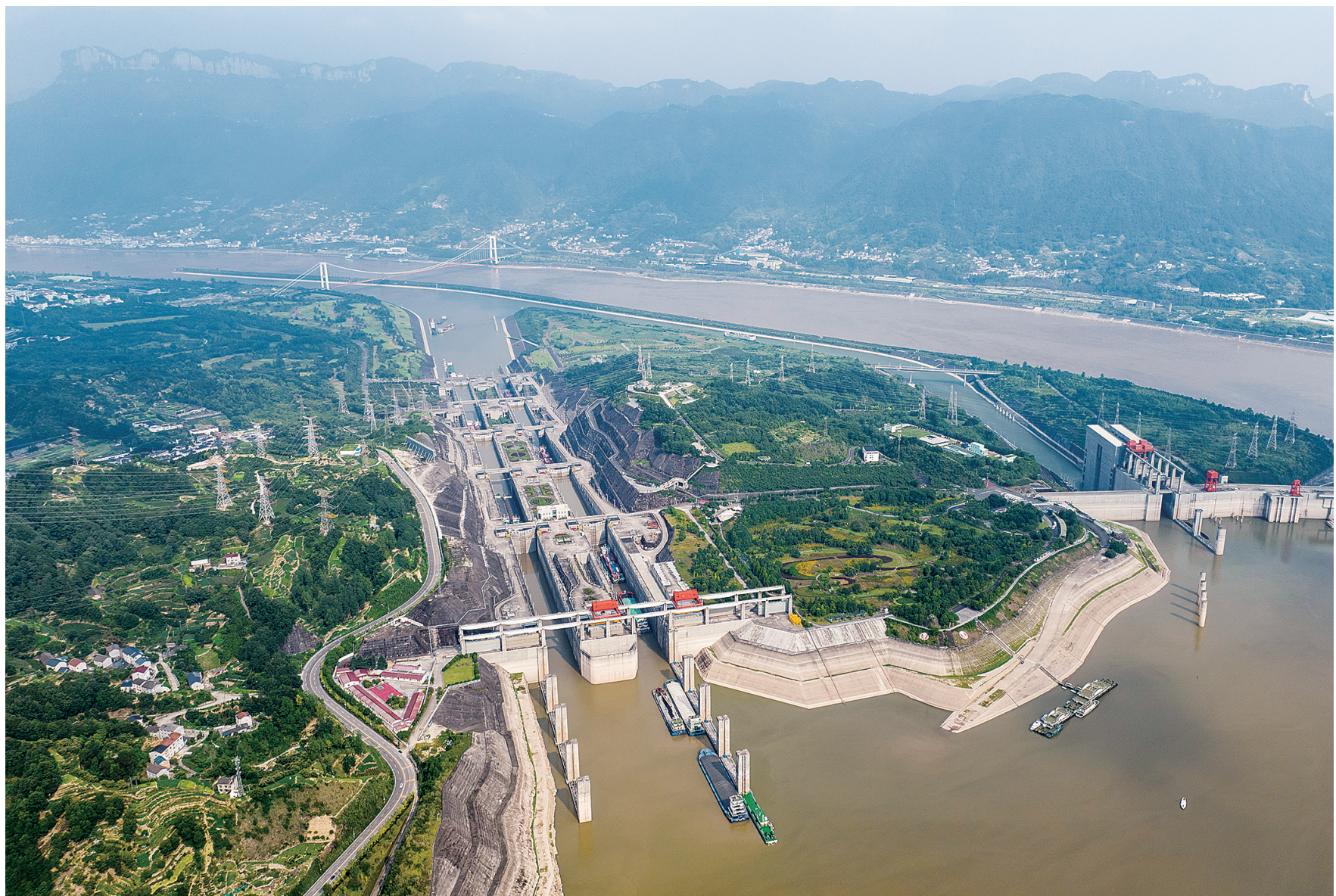
7月8日，船舶有序通过三峡五级船闸(无人机照片)。
