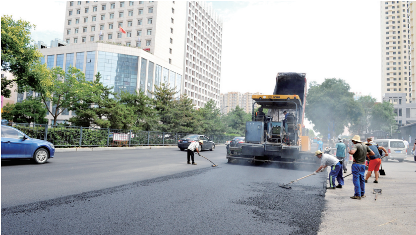
7月15日,市城市道路设施服务所工作人员为御河西路北都街至迎宾街路面摊铺沥青。近年来,御河西路交通负荷不断增大,导致该路段沥青路面出现了裂缝、坑槽等“病害”,存在安全隐患。为此,该所紧抓时机进行夏季道路养护施工,提升道路通行效率,进一步完善城市功能,助力全国文明城市创建。 本报记者 于宏摄
