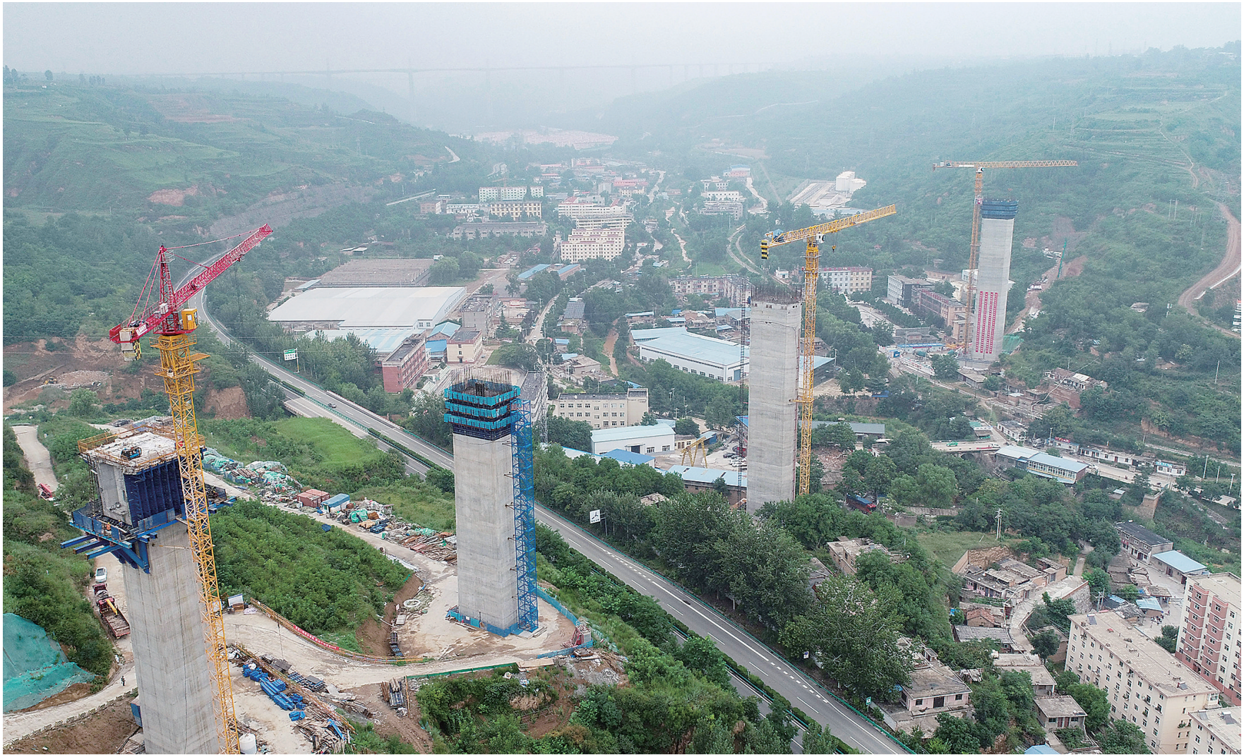
这是7月15日拍摄的西延高铁王家河特大桥施工现场(无人机照片)。当日,由中国铁建大桥工程局承建的西(安)延(安)高铁王家河特大桥主墩顺利封顶。王家河特大桥位于陕西省铜川市王益区境内,全长1066米,为西延高铁全线重点控制性工程。西延高铁是国家高速铁路网包(银)海高速铁路通道的重要组成部分。线路建成投入运营后,西安至延安的运行时间将从目前的2个半小时缩短至1小时左右。
