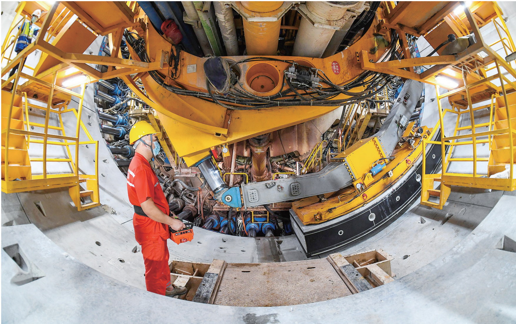
8月10日，施工人员在深江铁路珠江口隧道操作机械臂安装管片。近日，中铁十四局承建深（深圳）江（江门）铁路横穿珠江的珠江口隧道掘进到海底地质复杂段，直径超过13米的“深江1号”盾构机正以每天6到8米的速度，从东莞虎门向广州南沙方向攻坚掘进。 新华社记者 刘大伟摄
