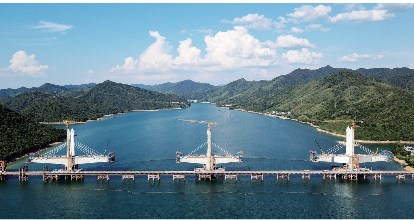
安徽黄山：高温下的铁路建设者
