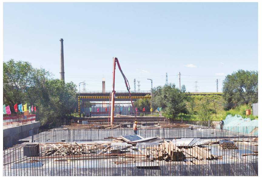
同泉路糖厂立交桥改建工程稳步推进。8月15日上午,记者在施工现场看到,一台泵车和数台罐车正在紧锣密鼓地进行新建箱涵工程西侧墙混凝土浇筑。
