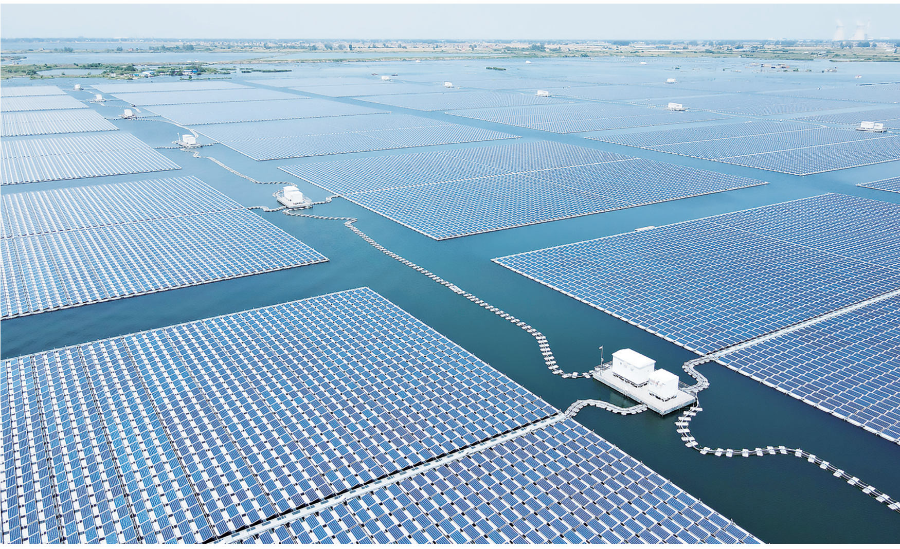
8月25日拍摄的颍上县毛圩水上光伏电站(无人机照片)。 近年来,安徽省阜阳市颍上县古城镇积极推进采煤沉陷区治理工作,将昔日的采煤沉陷区建设成水上光伏电站,既减少占用土地面积,又能生产清洁能源。据了解,古城镇已建成水面光伏电站并网装机容量130兆瓦,年均发电量1.36亿千瓦时,每年可节约标准煤约5.44万吨,减少二氧化碳排放量约13.56万吨。 新华社记者 黄博涵摄
