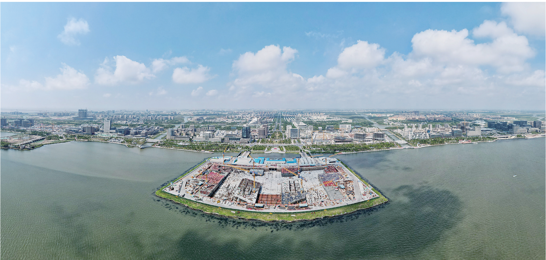
8月29日，空中俯瞰临港西岛金融中心项目工地（无人机照片）。当日，位于上海浦东新区的中建二局临港西岛金融中心项目开始最后一块楼板的混凝土浇筑，南北塔楼主体正式抵达零米层，金融中心地下主体部分施工圆满完成。临港西岛金融中心项目总建筑面积28.25万平方米，建筑主体为南北两座高200米的塔楼，建成后将成为临港新片区以金融总部办公为主体的大型城市综合体。 新华社记者 方喆摄
