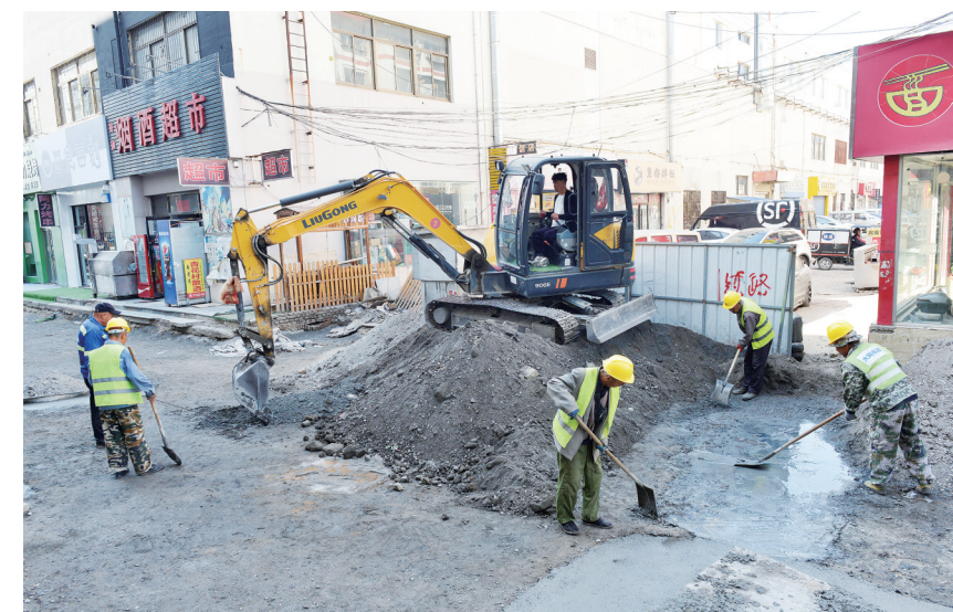
大同古城内街巷改造工程项目进展迅速。昨日,记者在贵儿寺街整治项目工程现场看到,专业管线土方回填施工已基本结束,工人们正在进行检查井的施工,为下一步混凝土垫层铺设做好准备,预计国庆期间开始路面石材铺装。本报记者 戎禹仁摄
