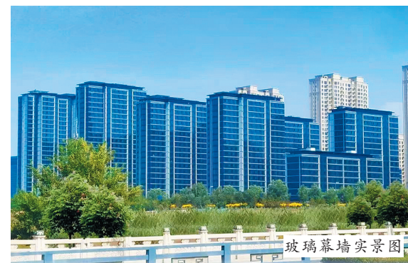
玻璃幕墙实景图
