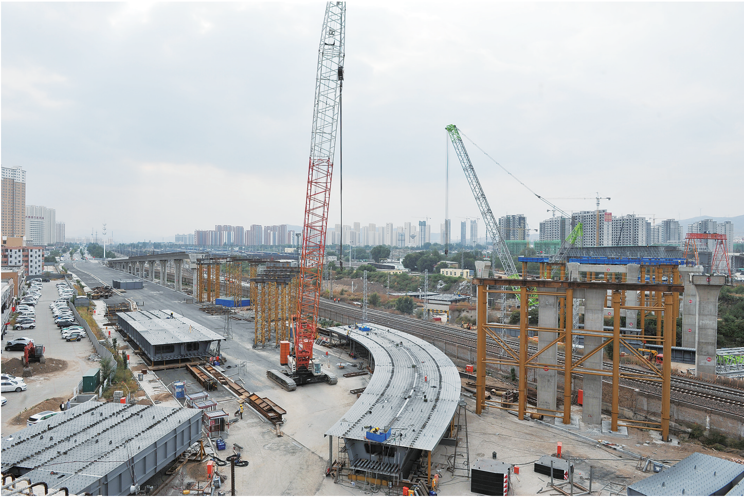
10月1日，平城街西延跨铁路桥梁新建工程项目工地，工人们正在进行钢箱梁焊接。 国庆期间，我市各重点工程依然奋战正酣，建设者们加班加点抢工期、赶进度，确保各项工程顺利推进。 本报记者 于宏摄
